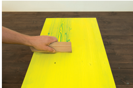
Die noch nasse Farbe wird nun mit einem Gleitabzieher oder einer Silikonlippe abgezogen. (Foto: Osmo)
