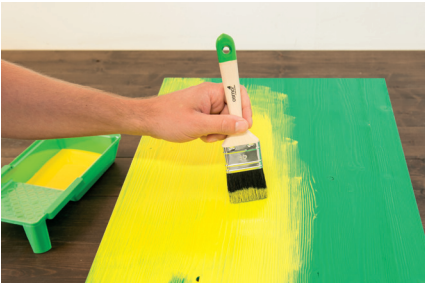
Nach mindestens 24 Stunden Trockenzeit kann der Anstrich im zweiten Farbton erfolgen. (Foto: Osmo)
