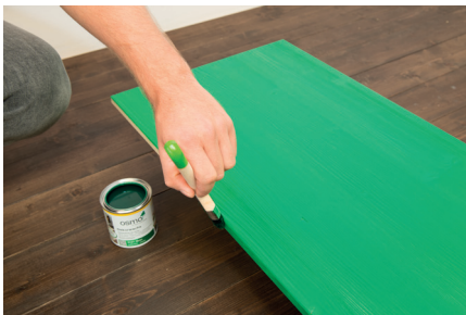
Anschließend wird der erste Farbtön mit einem Pinsel oder einer Mikrofaser-Rolle aufgetragen. (Foto: Osmo)
