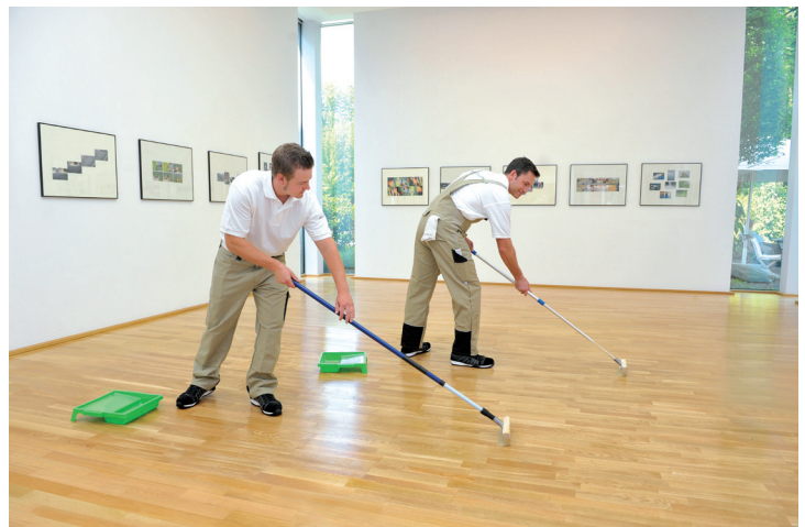
Zeitersparnis: Dank schneller Trocknung sind mit dem neuen Hartwachs-Öl zwei Anstriche innerhalb eines Tages möglich. (Foto: Osmo)
